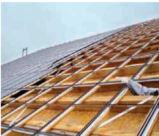
Abb. 17: Fotovoltaik auf bestehendem Dach mit horizontaler Luftführung und seitlichem Sammelkanal
